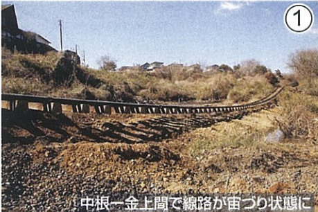
中根-金上間で線路が宙ぶり状態に
