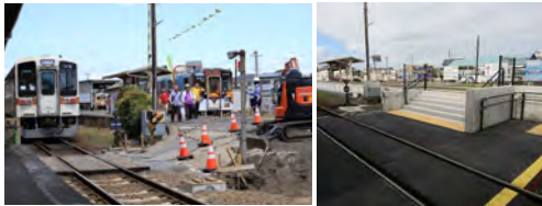
那珂湊駅の下り線ホーム階段改良工事ビフォー&アフター(右は完成した10月7日)
