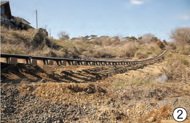
新堀団地北側の溜め池(①手前左)が地震で決壊。線路の路盤とともに盛土が崖下の田んぼにまで流出し、線路は約100mにわたり吊り橋のように宙に浮いた=写真①② 線路が波打ったり、枕木がずれた箇所も見受けられた(那珂湊一殿山間)=写真③
