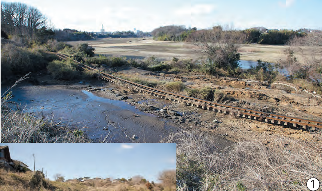
新堀団地北側の溜め池(①手前左)が地震で決壊。線路の路盤とともに盛土が崖下の田んぼにまで流出し、線路は約100mにわたり吊り橋のように宙に浮いた=写真①② 線路が波打ったり、枕木がずれた箇所も見受けられた(那珂湊一殿山間)=写真③
