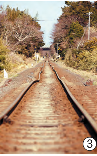
新堀団地北側の溜め池(①手前左)が地震で決壊。線路の路盤とともに盛土が崖下の田んぼにまで流出し、線路は約100mにわたり吊り橋のように宙に浮いた=写真①② 線路が波打ったり、枕木がずれた箇所も見受けられた(那珂湊一殿山間)=写真③
